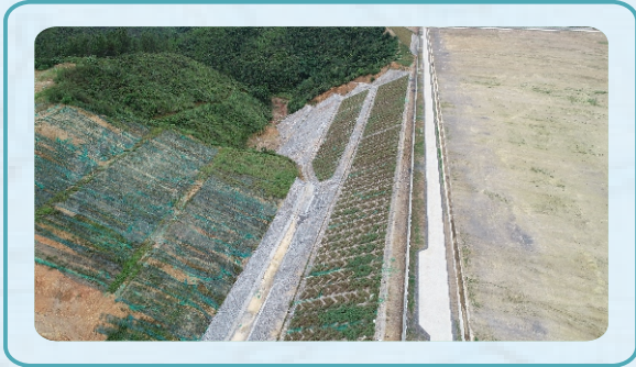
梧州机场迁建工程边坡绿化
