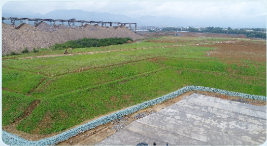
大藤峡水利枢纽左岸表土暂存场
