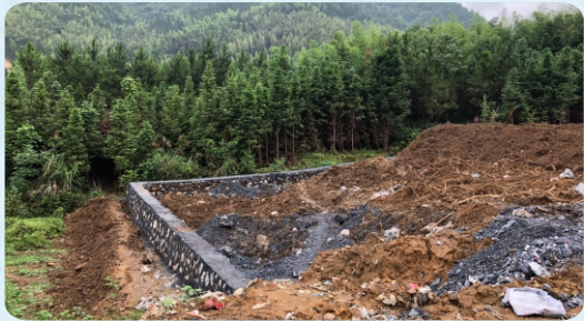
莽山水库石灰冲弃渣场
