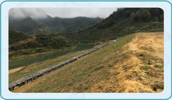
黄家湾水利枢纽弃场拦挡
