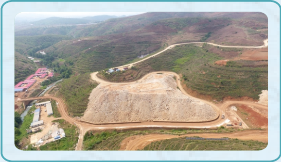
云南省德厚水库枢纽区1#弃渣场
