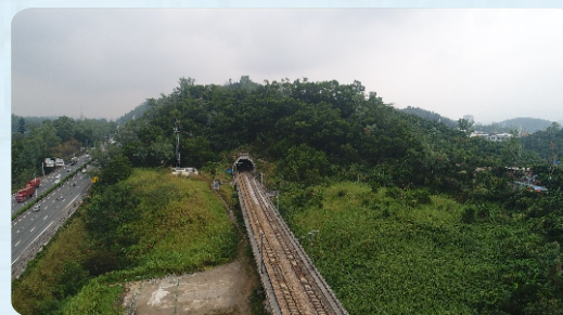
厦深高铁渣场绿化
