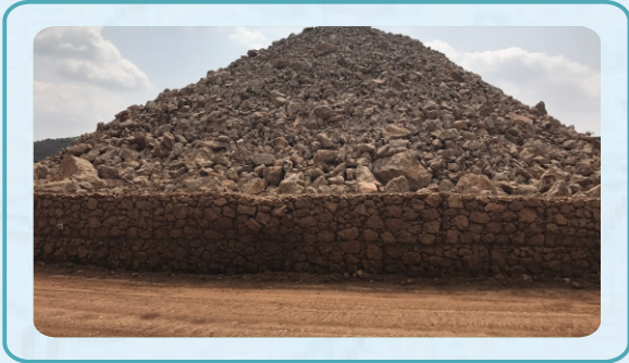
云南省德厚水库枢纽区1#弃渣场
