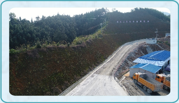
落久水利枢纽边坡防护、道路排水
