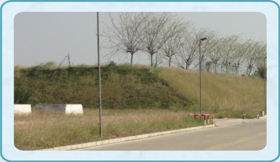
昌江核电一期渣场边坡防护
