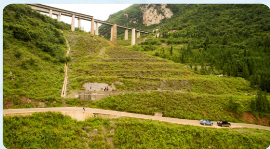
六盘水至沾益段增建第二线工程 曹家沟隧道进口渣场
