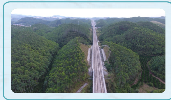
贵广铁路路基防护
