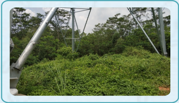
滇西北工程直流线路3568号塔植被恢复
