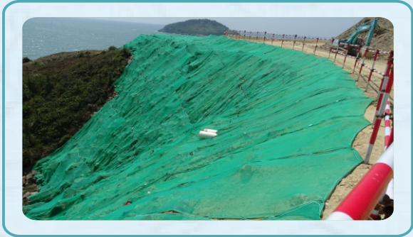
太平岭核电临时苫盖措施
