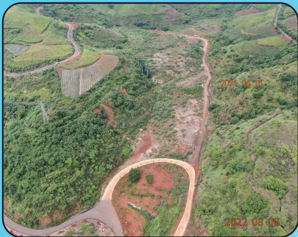
云南德厚水库工程枢纽区1#弃渣场
