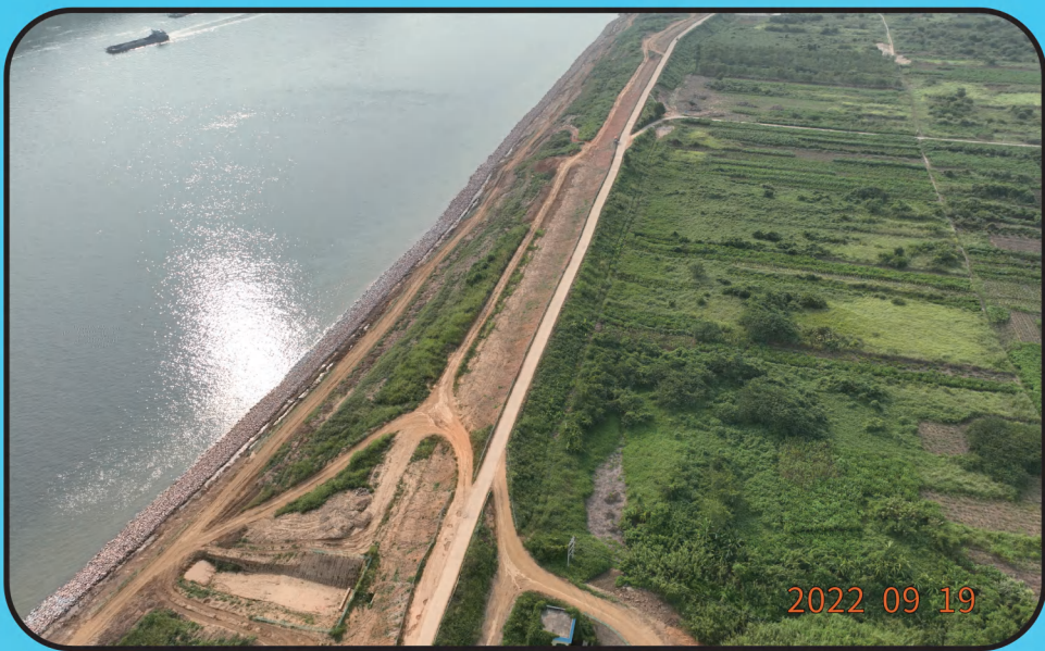
广东省西江干流治理工程（肇庆段）江滨大堤
