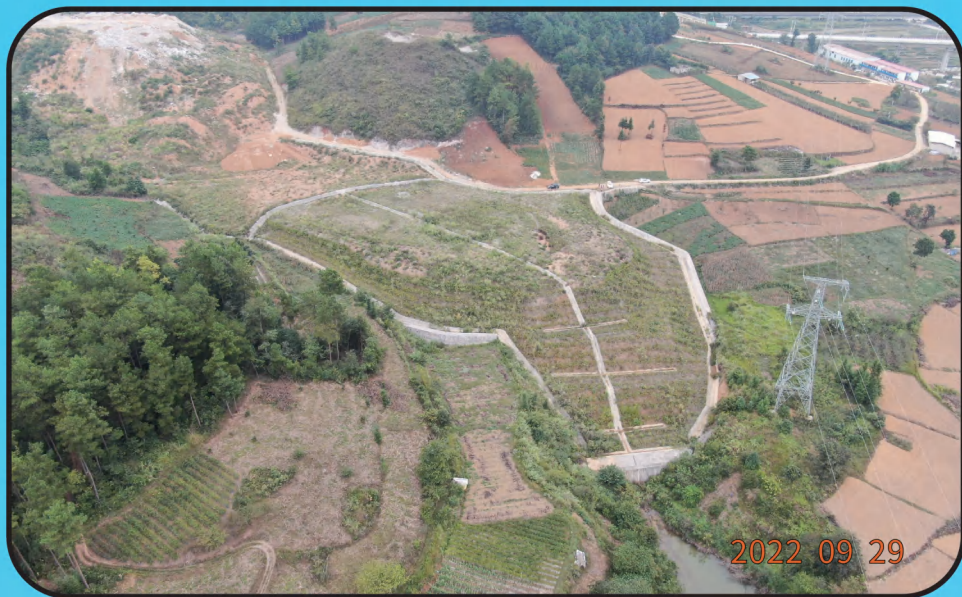
贵南铁路（贵州段）新何家庄隧道弃渣场
