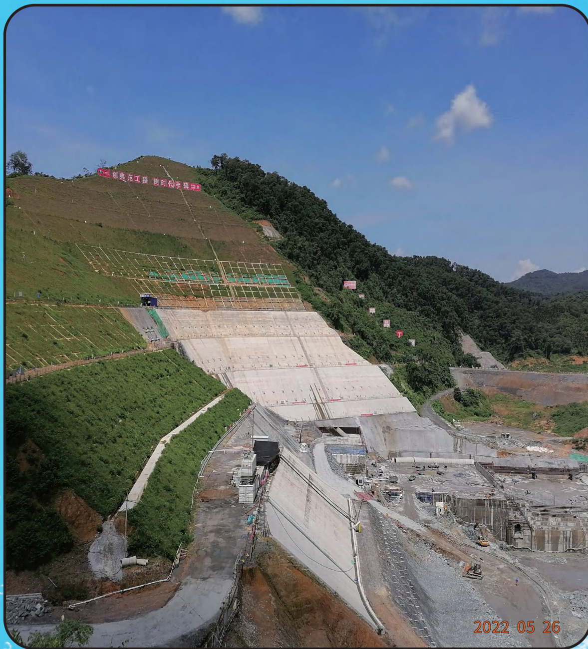
南渡江迈湾水利枢纽工程右坝肩边坡防护
