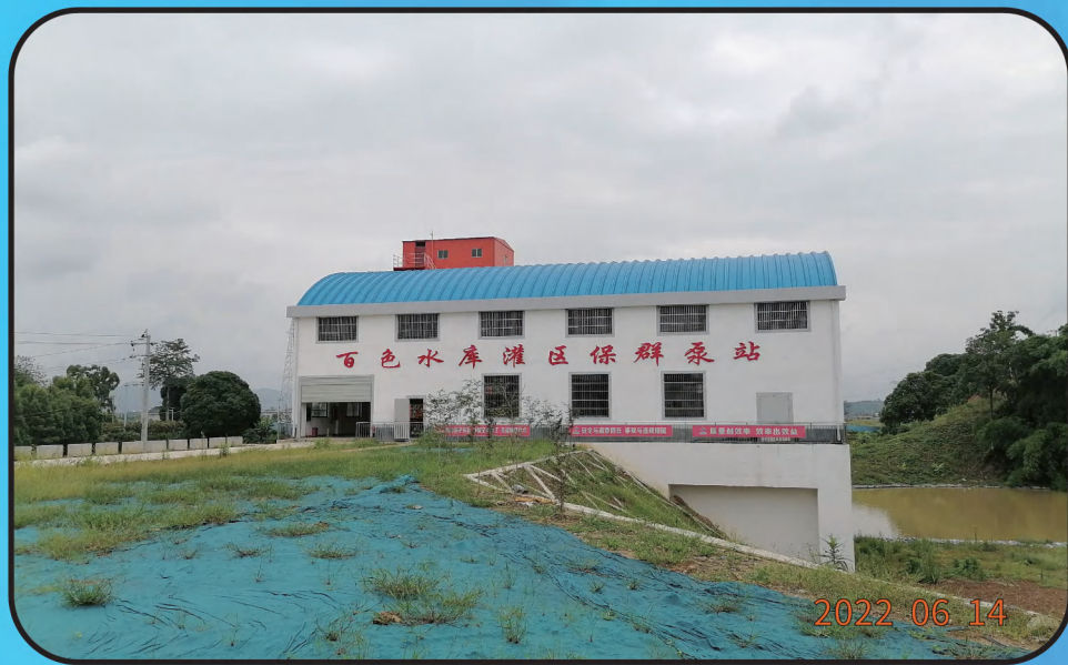
广西百色水库灌区保群泵站
