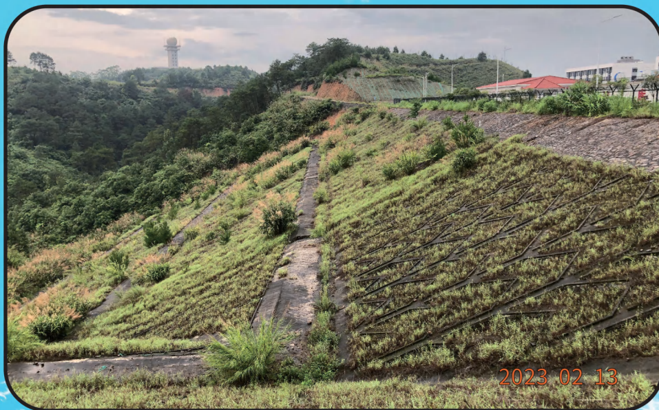
梧州机场迁建工程边坡防护
