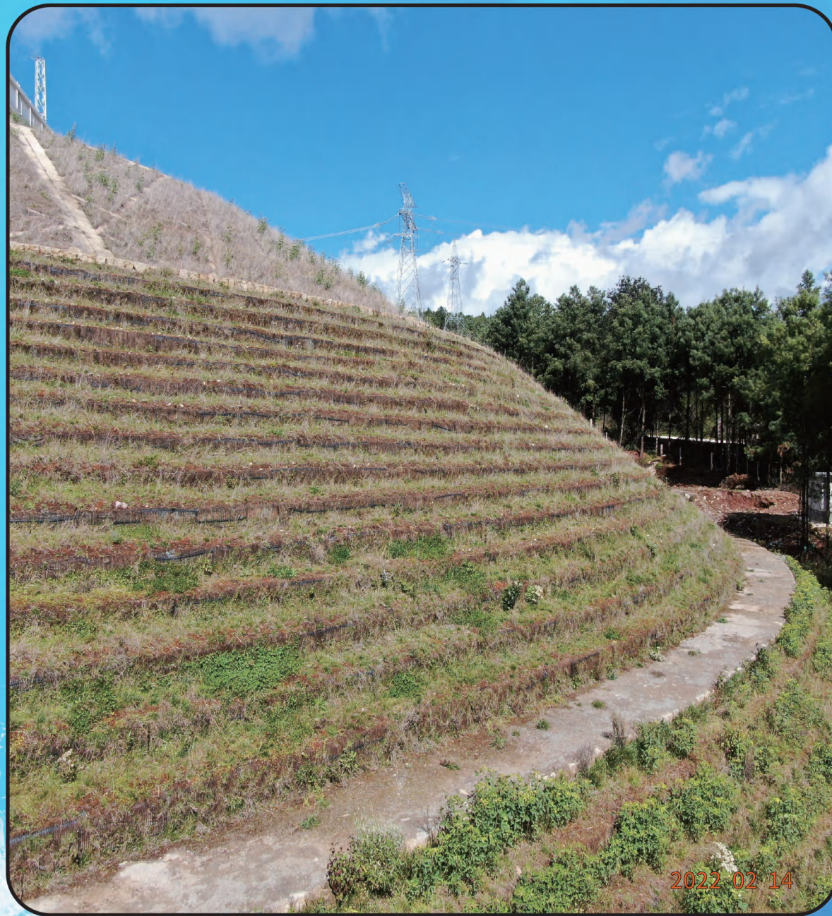
云贵互联通道工程禄劝站边坡护坡
