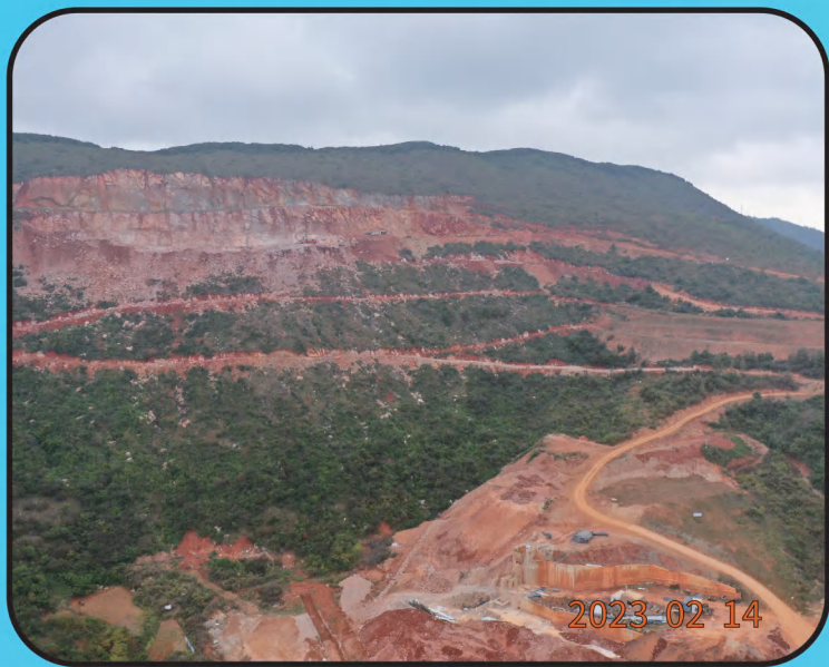
滇中引水工程照壁山石料场防护措施不完善
