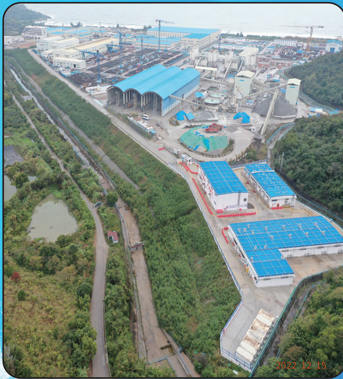
广东太平岭核电一期工程施工生产生活区填方边坡
