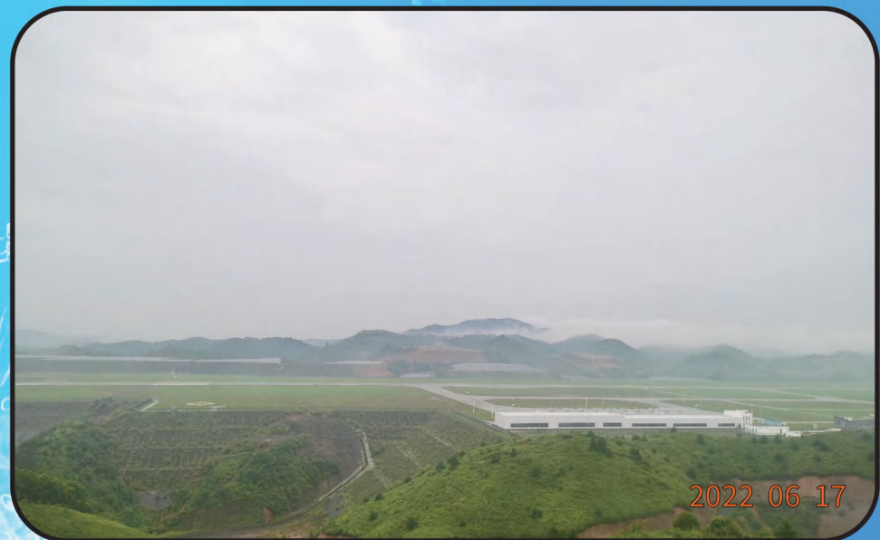
玉林民用机场飞行区及边坡防护
