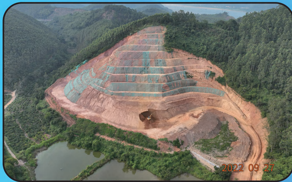
广东省西江干流治理工程（云浮段）西降塘取土场
