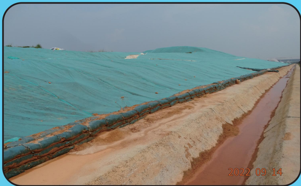
广东湛江机场迁建工程预留区临时防护
