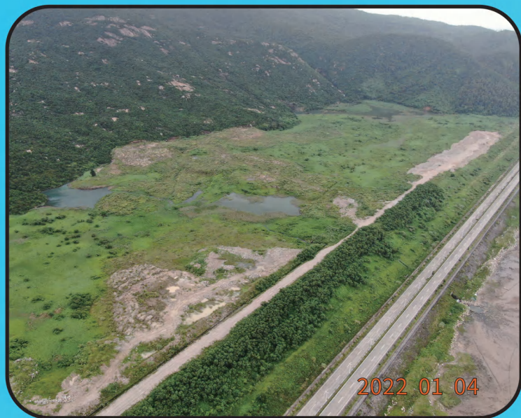
台山核电一期工程弃渣场
