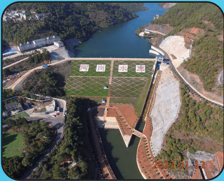
云南阿岗水库工程
