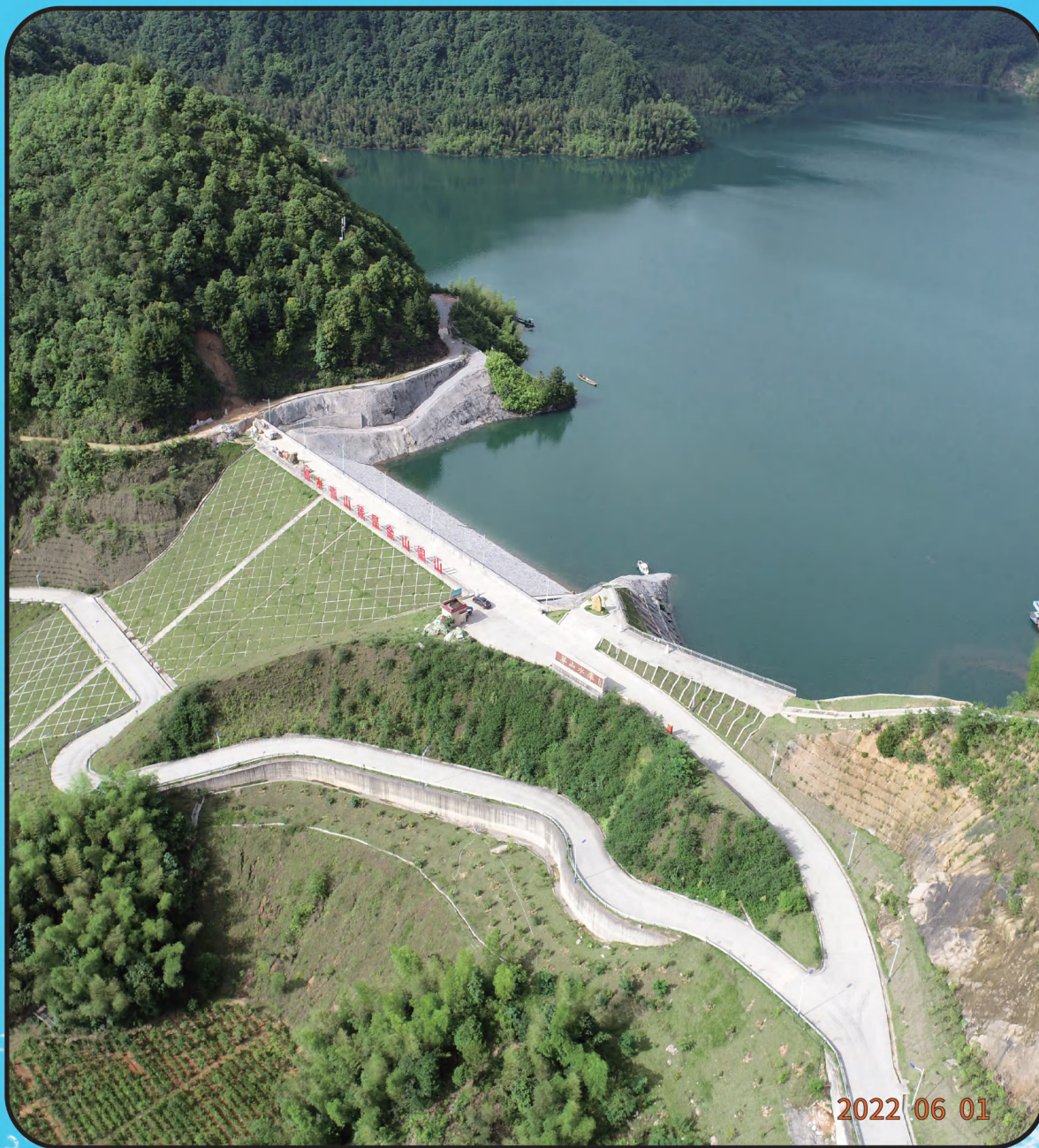
湖南莽山水库工程副坝边坡防护
