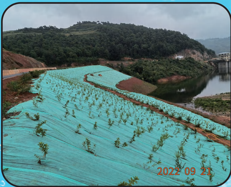
云南阿岗水库工程边坡防护
