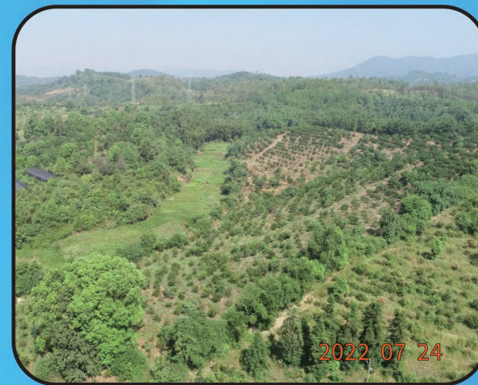
潜江-韶关输气管道工程（珠江流域） 作业带植被恢复
