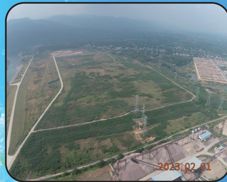
大藤峡水利枢纽工程弃渣场
