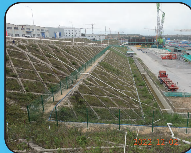
海南昌江核电厂3、4号机组边坡防护
