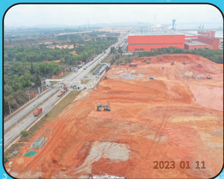
广东陆丰核电5、6号机组项目
