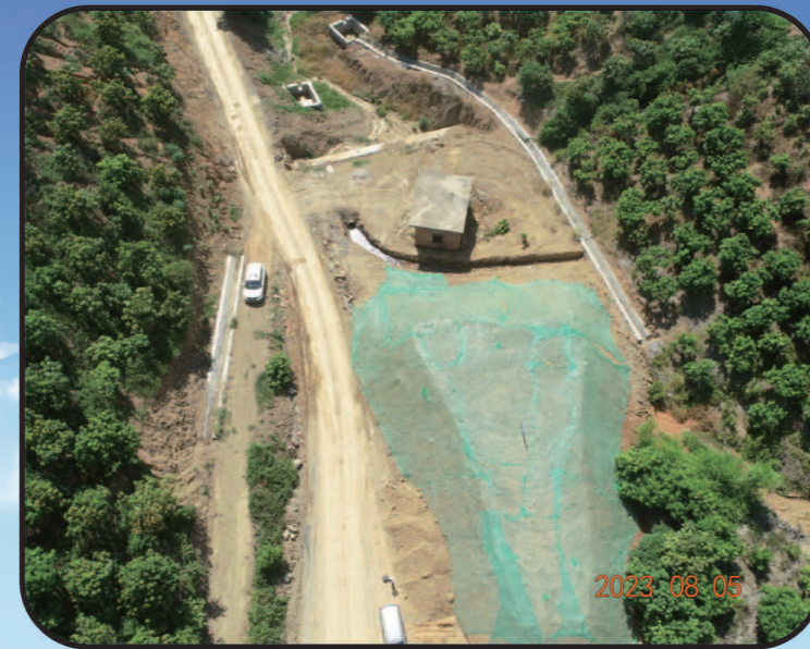
百色水库灌区工程北干渠那隆弃渣场
