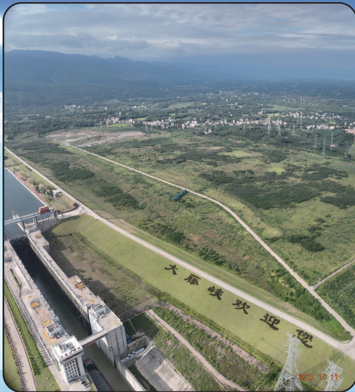
大藤峡水利枢纽工程左岸弃渣场
