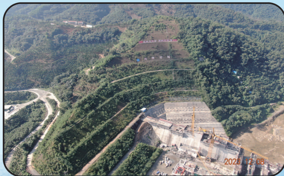
南渡江迈湾水利枢纽工程右坝肩边坡防护
