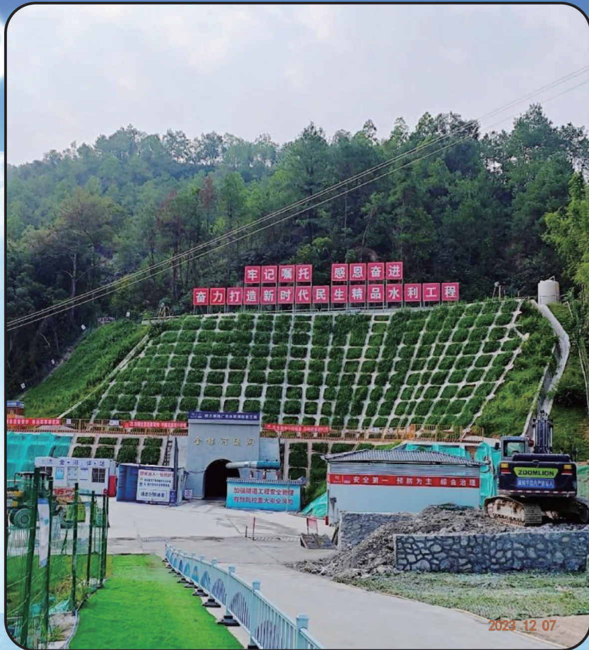
环北部湾广东水资源配置工程金银河隧洞边坡绿化
