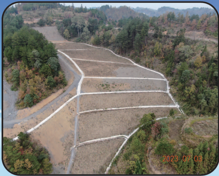
贵南铁路（贵州段）播尧1号弃渣场
