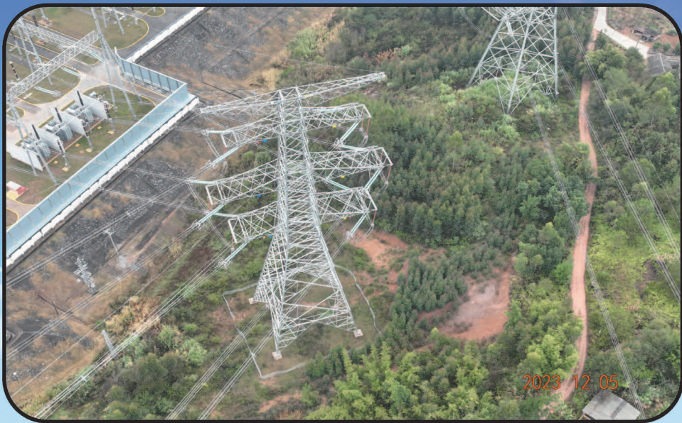
闽粤联网广东段1#塔基
