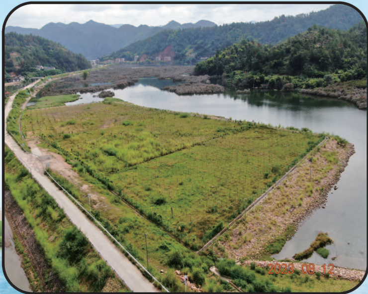
广东韩江高陂水利枢纽工程小党溪弃渣场
