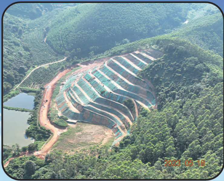
广东省西江干流治理工程（云浮段）西降塘取土场
