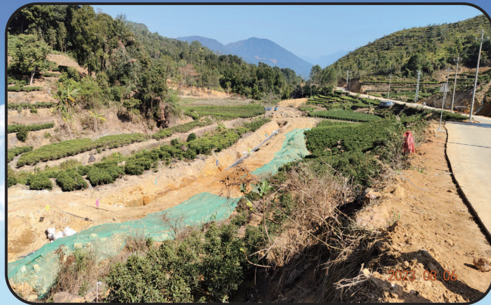
闽粤支干线工程（潮漳段）线路二标段管道作业区
