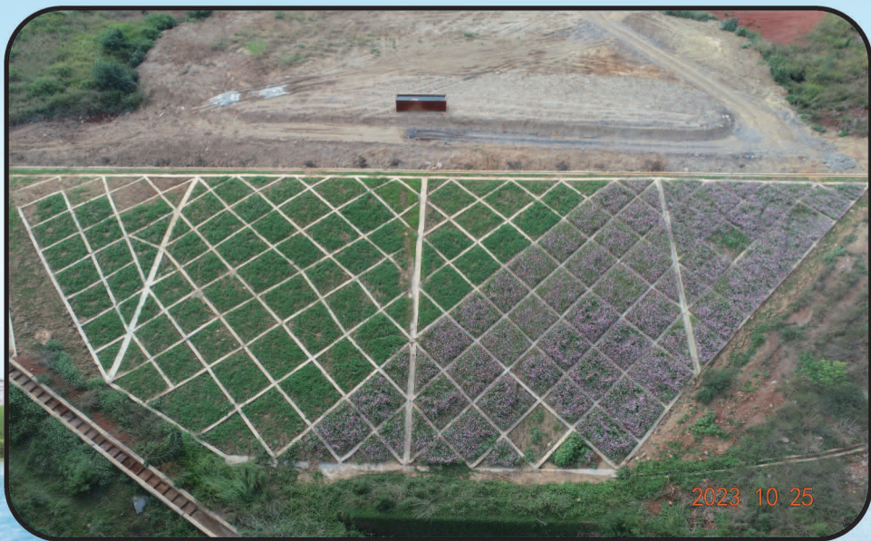
云南滇中引水工程五里冲弃渣场植草护坡
