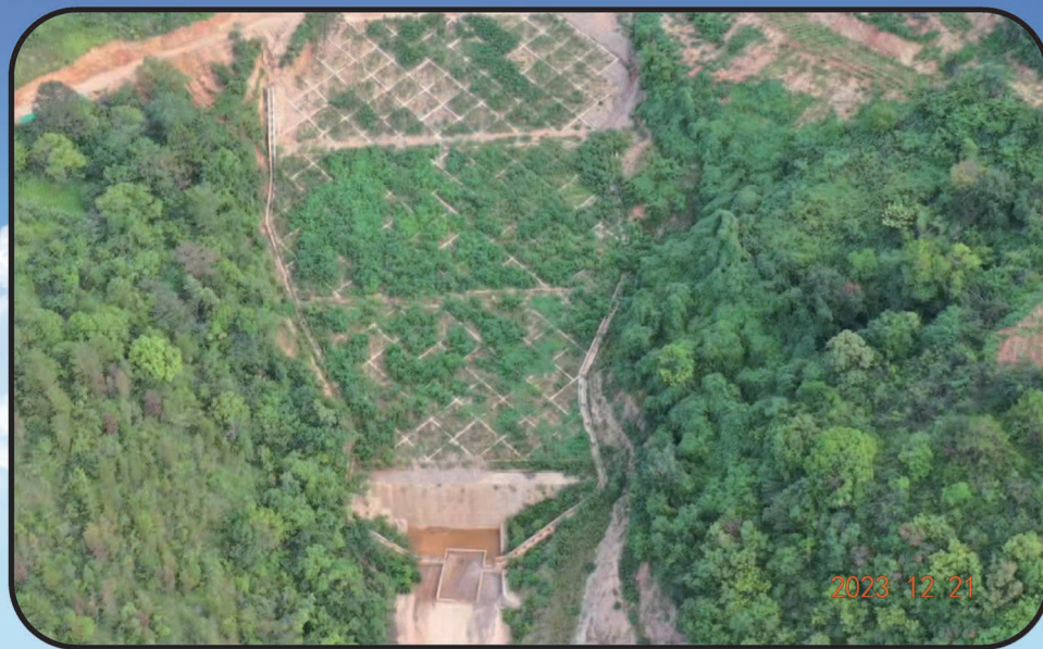
云南滇中引水工程曲江弃渣场
