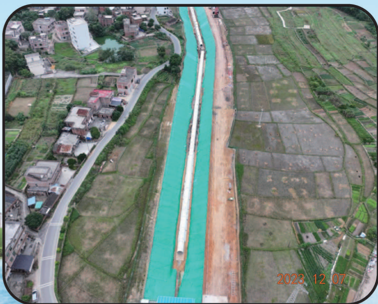
环北部湾广东水资源配置工程埋管段基坑边坡苫盖
