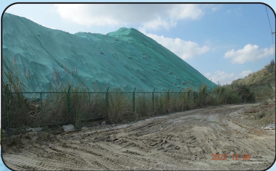
海南昌江小型堆示范工程弃渣场防护
