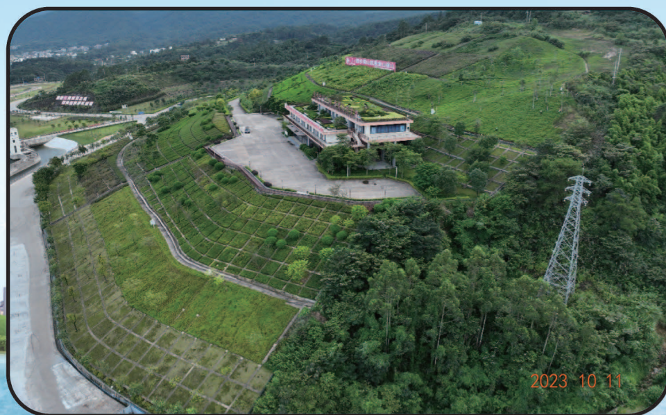
大藤峡水利枢纽工程右岸坝肩防护
