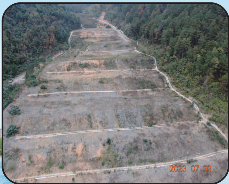
贵南铁路（贵州段）荔波弃渣场
