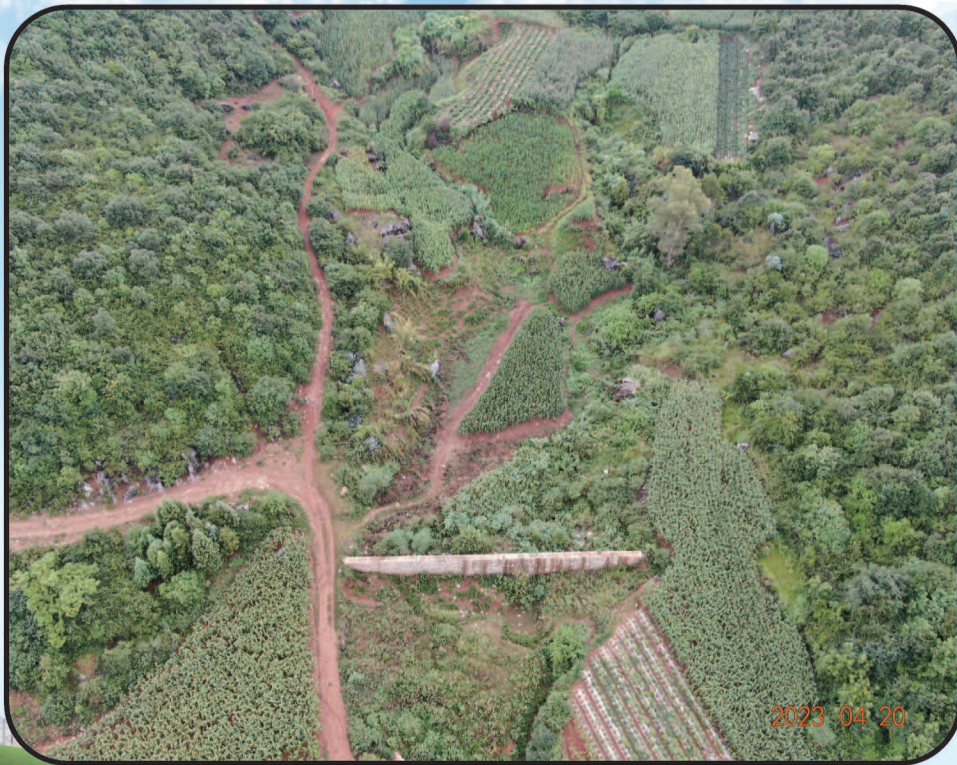
云南德厚水库输水区弃渣场
