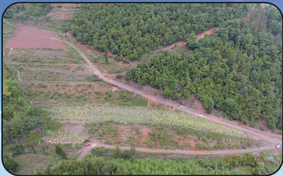
云南阿岗水库工程弃渣场
